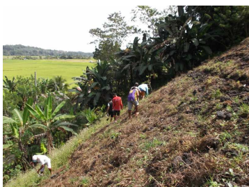
2013年 整地作業中
